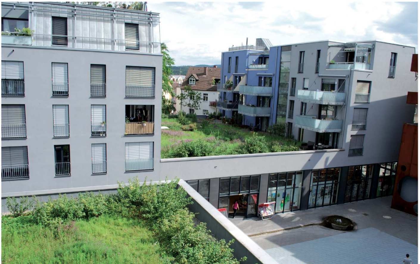
Blick über zwei Flächen der Obst- und Kräuterdächer in Radolfzell
